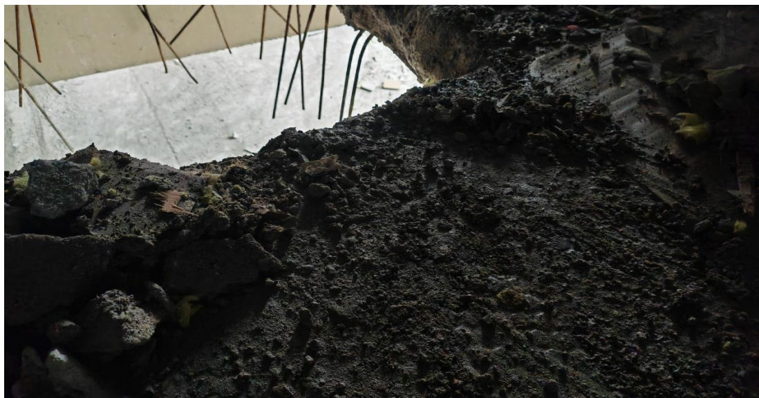
图3 6楼临时下料洞口周边环境
