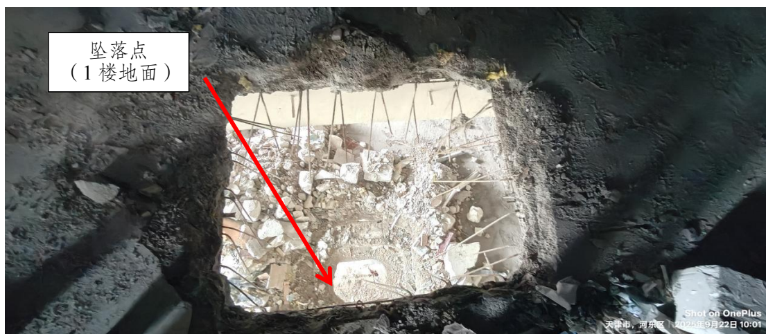
图1 6楼临时下料洞口（俯视）
