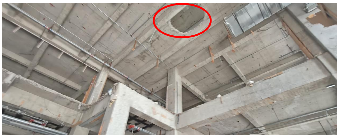
图4 6楼临时下料洞口（仰视）
