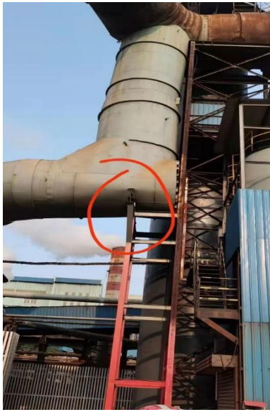
图2 管道凹陷
