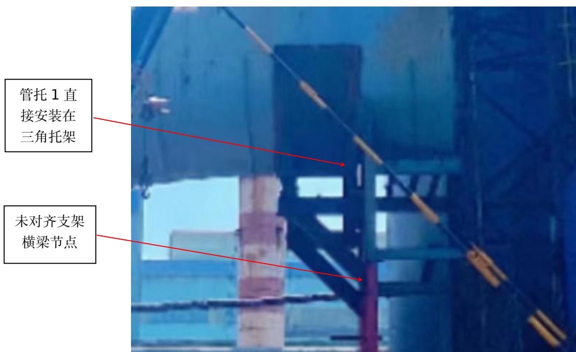
图 9-2 实际施工情况
