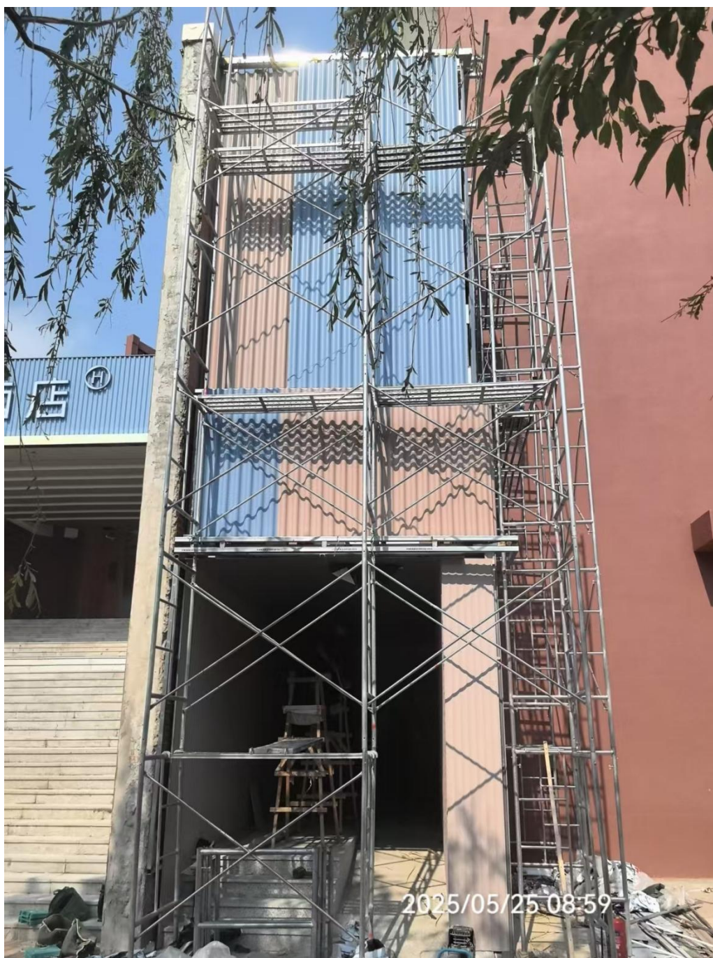
图二 涉事脚手架拆除前图片（刘某摄于事故当天）
