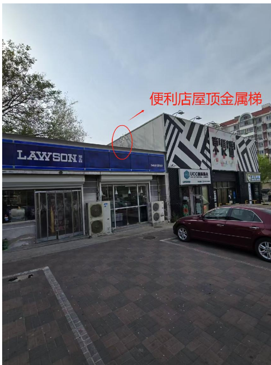
图 3 便利店屋顶金属梯
