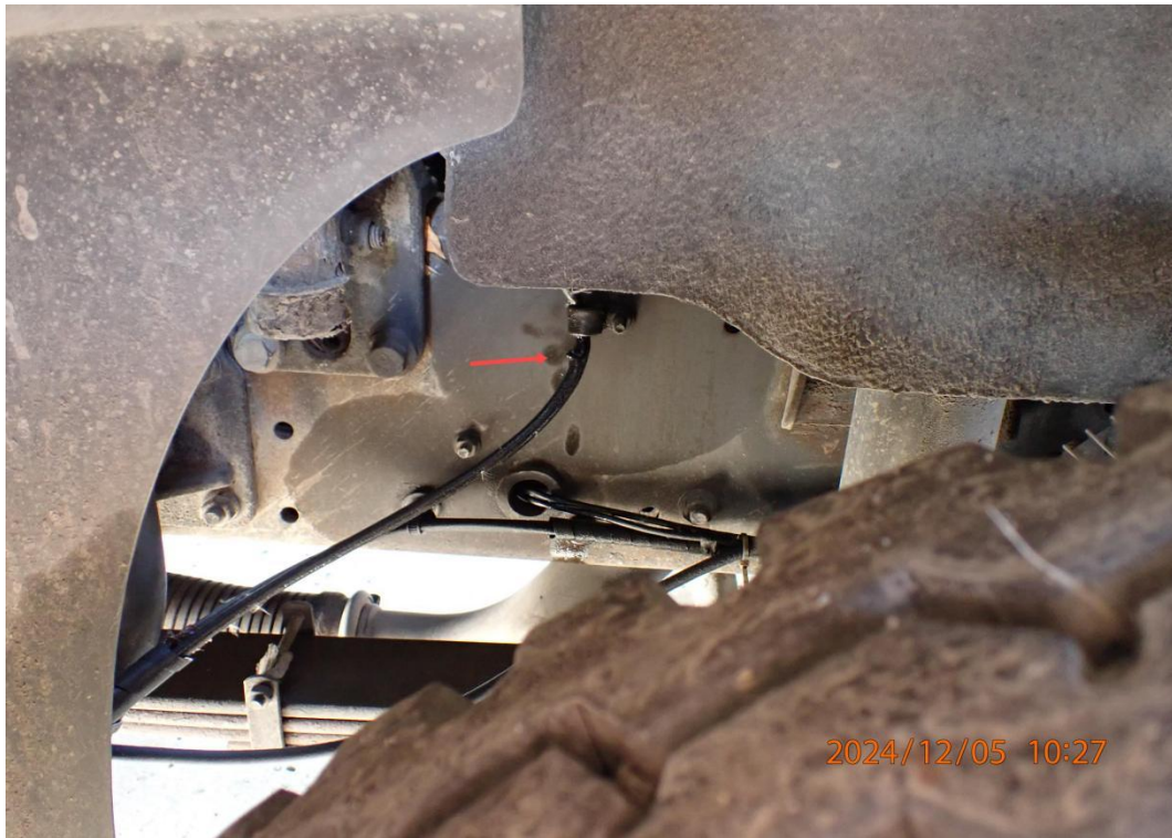
图三 液压油管漏油部位
