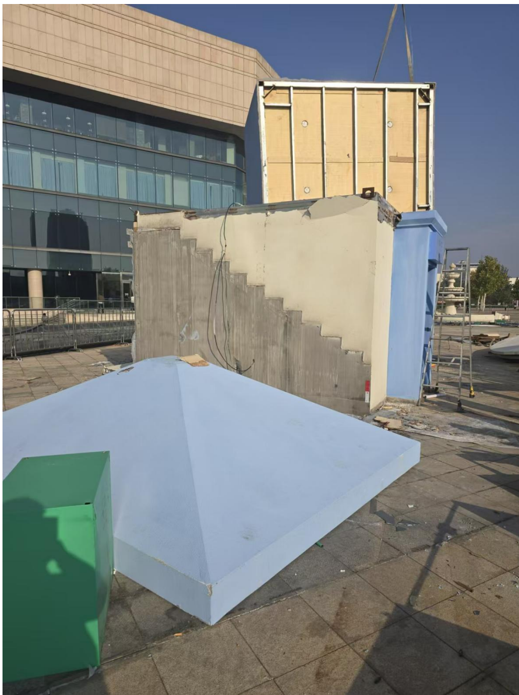
图 1 现场勘验图片
