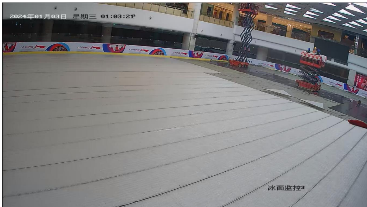
图 4 高处作业情况
