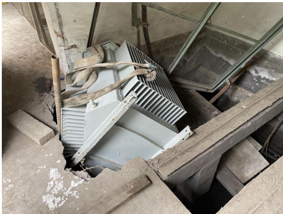
图 4: 纪 3709 甲变压器倾覆位置
