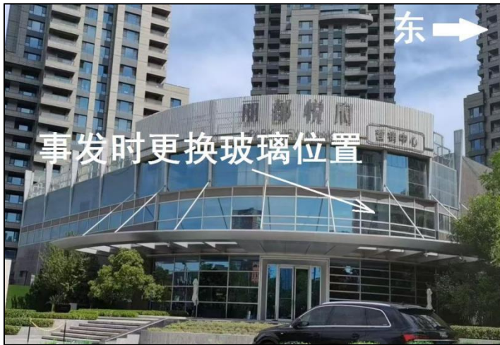
图 1 将台西路 10 号院 4 号楼
