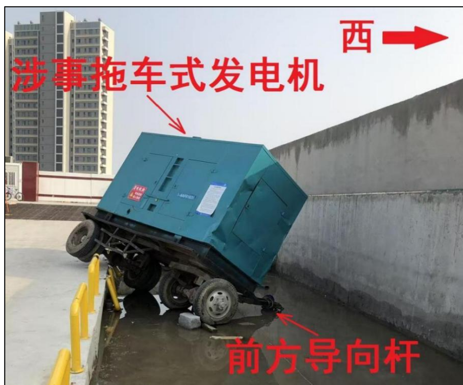
图 2 事故现场情况
