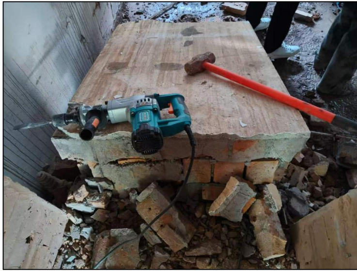
图 2 拆除门洞墙体作业使用的电镐和锤子
