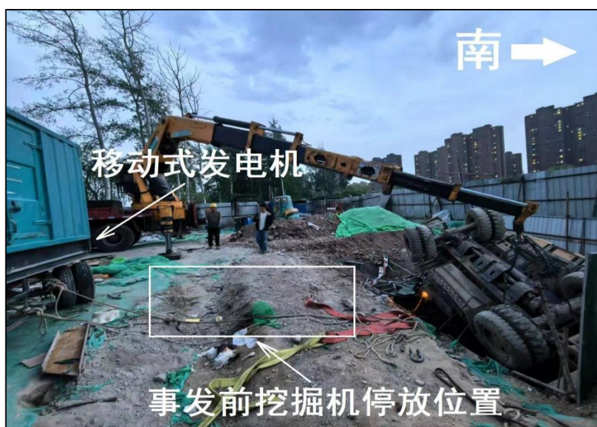
图 2 事发基坑北侧周边情况
