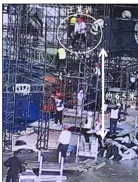
图 1 灯光架拆除作业现场
