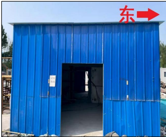
图 1 涉事试验棚整体情况
