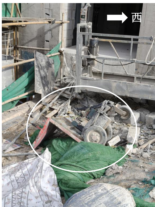
图 2 坠落的电动平板车
