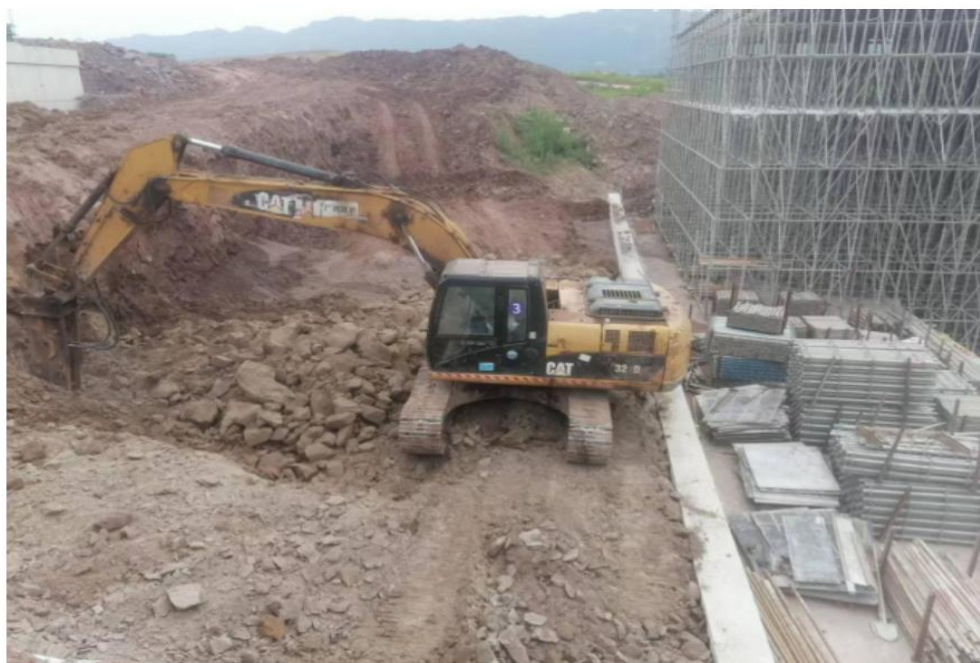
图二、现浇箱梁满堂模板支撑的场地开挖照片一
