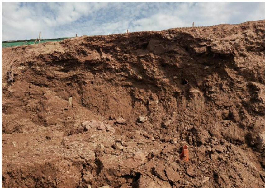
图五、坍塌部位照片一
