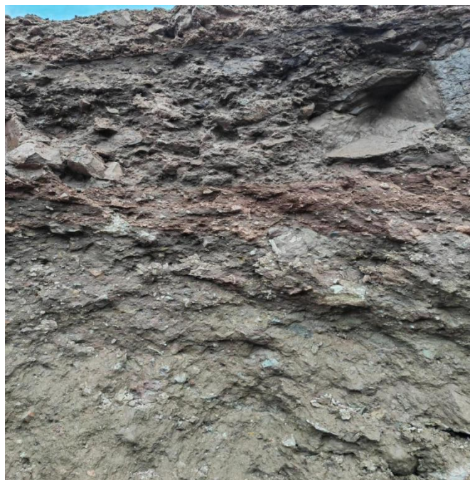
图六、坍塌部位照片二
