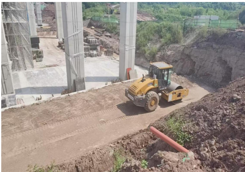
图三、现浇箱梁满堂模板支撑的场地开挖照片二
