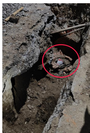
图 4 污水井井底基础
