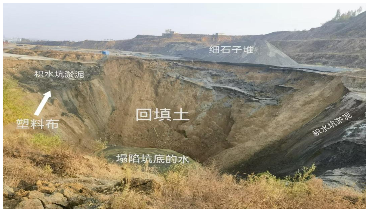
图2 西露天坑塌陷后现场照片（2024年11月3日）
