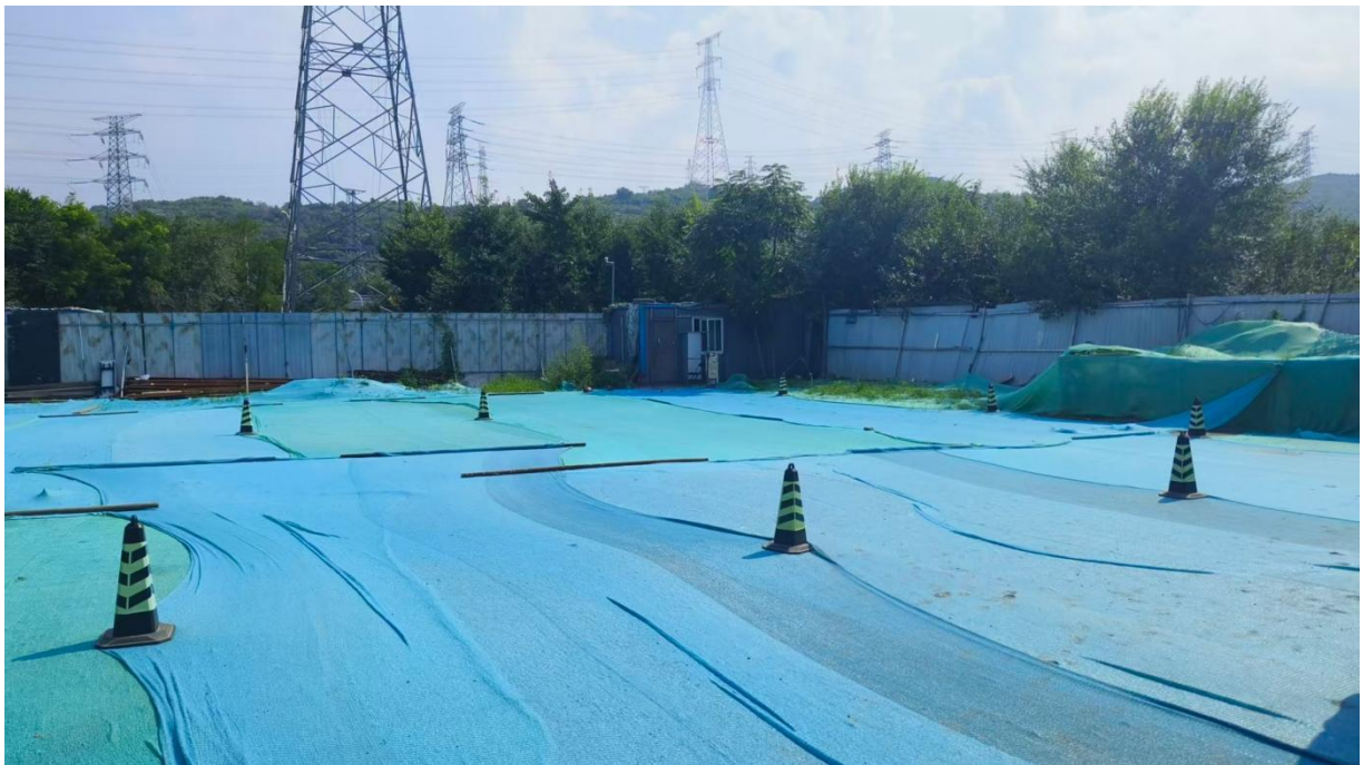
整改后现场情况
