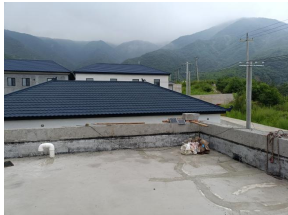
二楼楼顶平台
