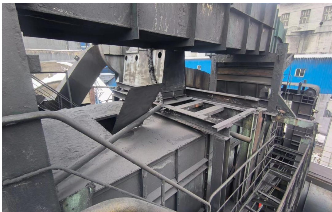
1 # 拦焦车集尘罩上部罩及检修门（人孔）
