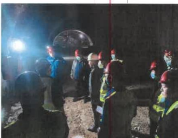
斜井左线小里程上台阶检查
