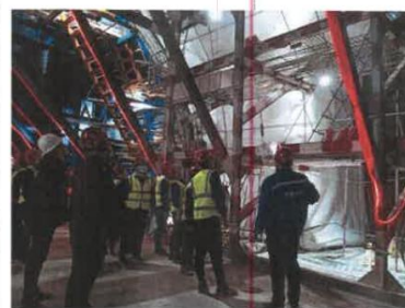
斜井左线小里程防水板台车检查
