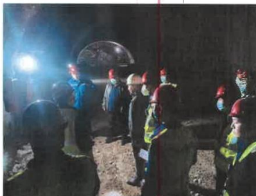
斜井左线小里程上台阶检查
