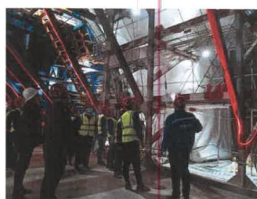
斜井左线小里程防水板台车检查
