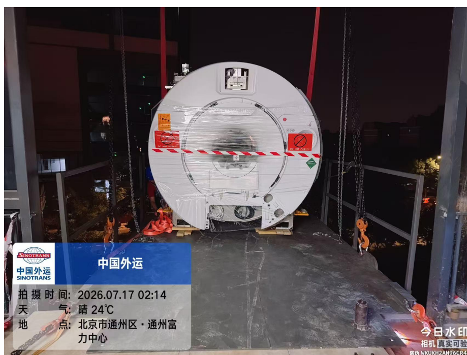
图三：事发作业吊装情况 1
