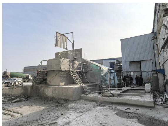
图 4 浆水池与洗罐区（自北向南拍摄）
