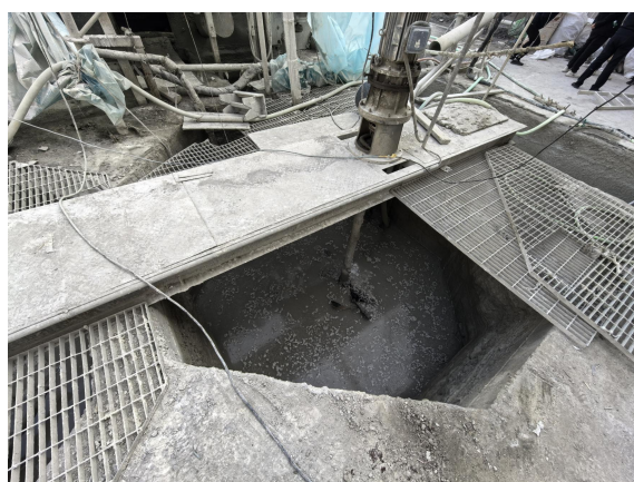
图 3 南侧浆水池情况
