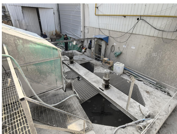
图 2 浆水池区域（自北向南拍摄）
