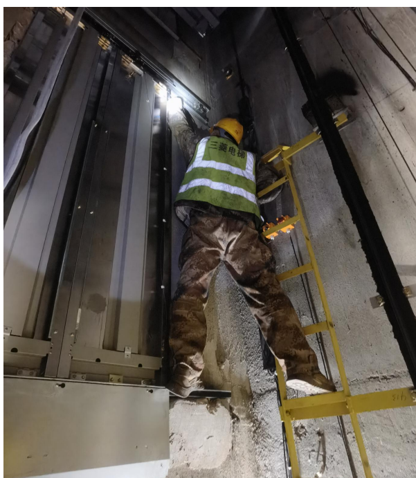
图 3 工人现场模拟消防穿线操作
