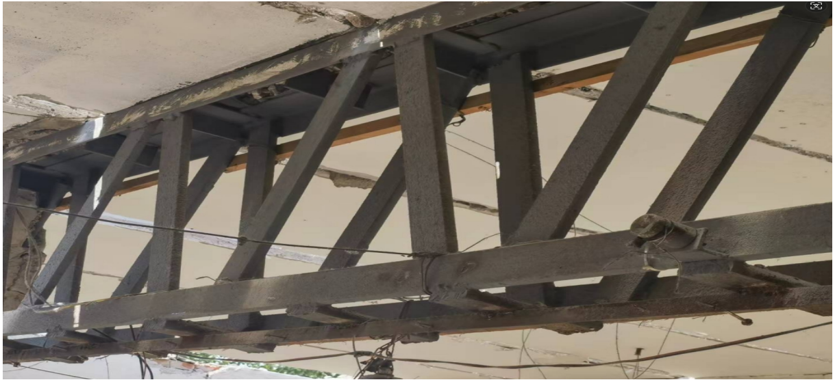
图3 钢桁架梁照片
