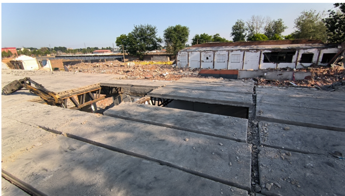
图 8 2~6 轴间预制板板缝间的混凝土已破碎并分割完毕
