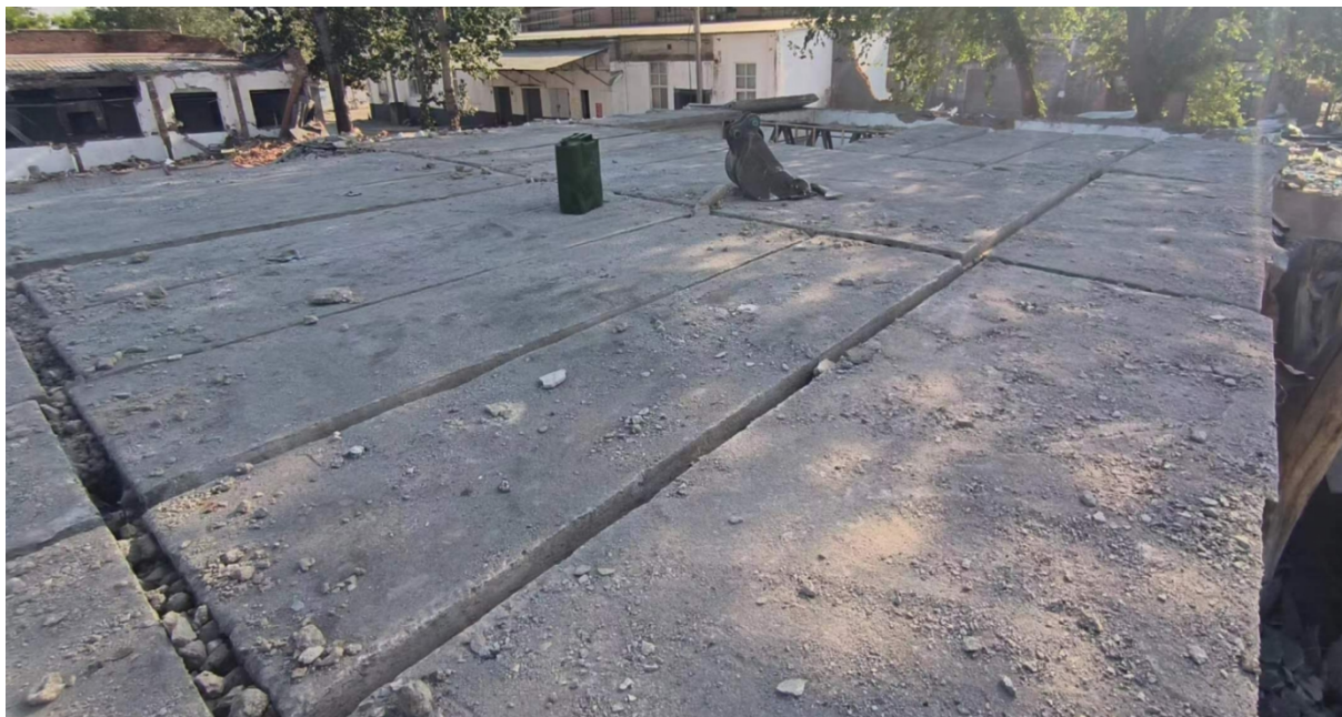
图 7 1~2 轴间的部分预制板缝隙已拆除
