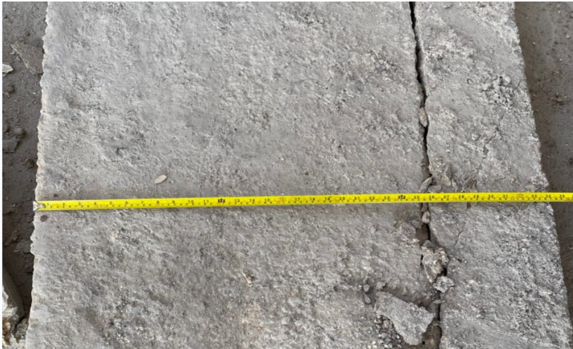
图4 屋面预制板板宽检测照片
