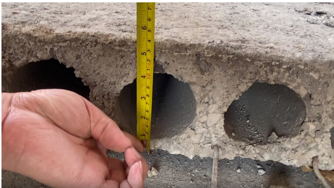
图5 屋面预制板板厚检测照片
