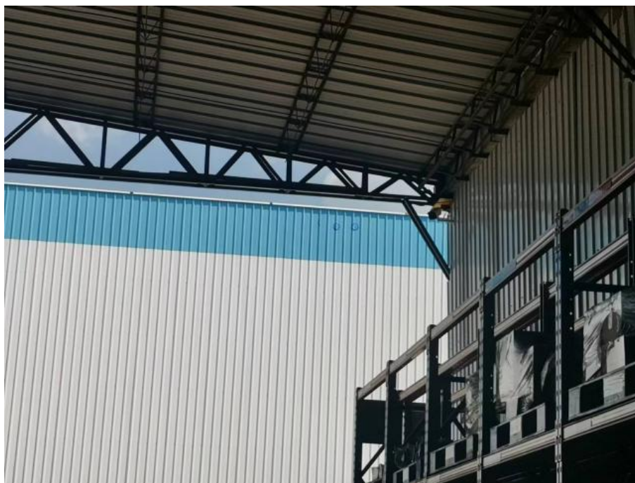
图 7 新增一个监控，共两个监控可覆盖备件库全区域
