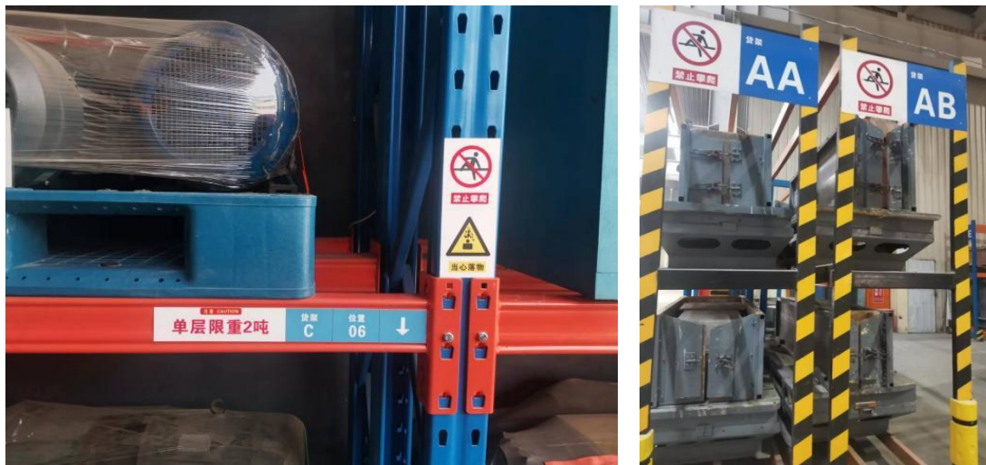
图 4 备件库货架现状（限重和警示标识、编码、加固措施等）
