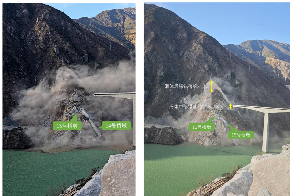
图 3 红旗大桥右岸引桥垮塌后现场照片
