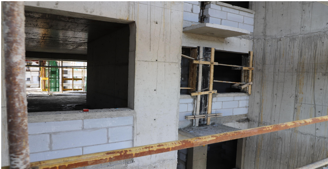
图 1 施工楼层窗口情况
