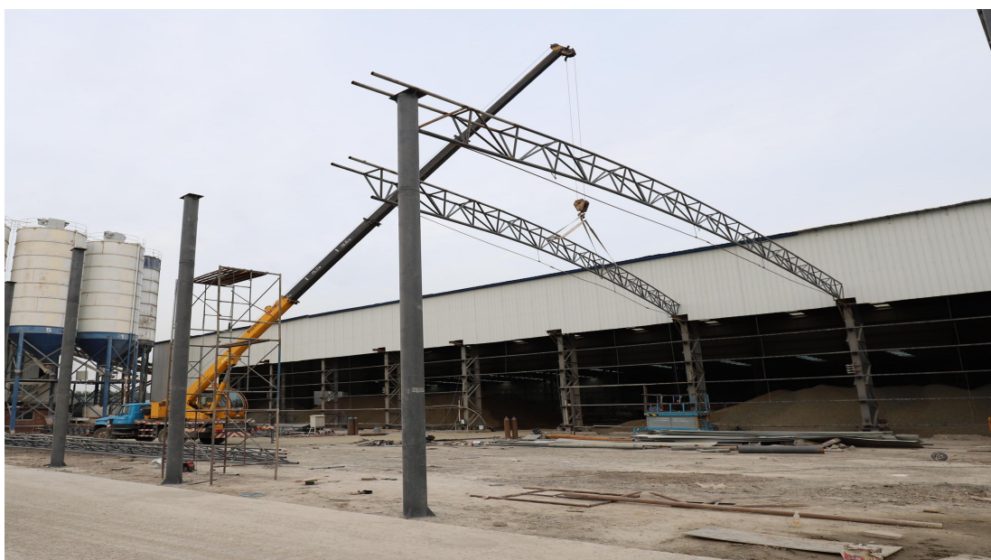
安装横梁现场照片
