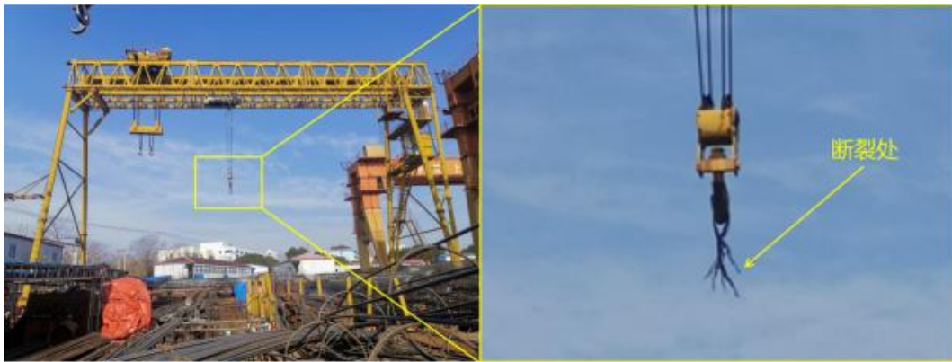
图2 事故现场全貌及索具钢丝绳断裂位置
