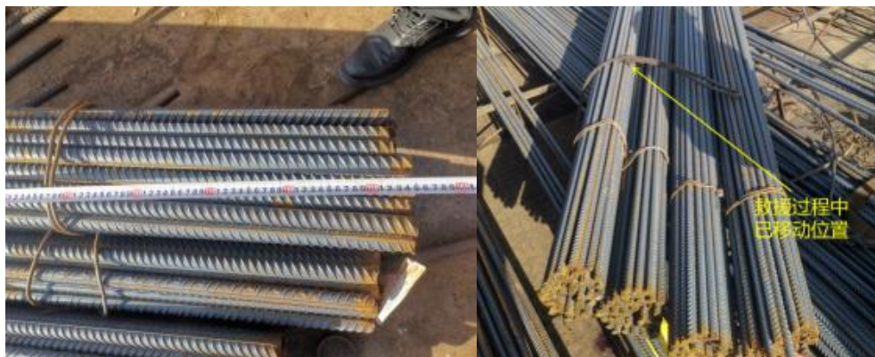
图 6 起吊钢筋时的捆绑绳（吊点）位置
