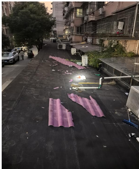
图二 38 号楼南侧非机动车库顶照片
