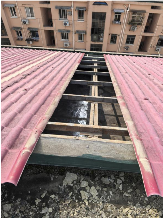
图三 38 号楼屋顶照片
