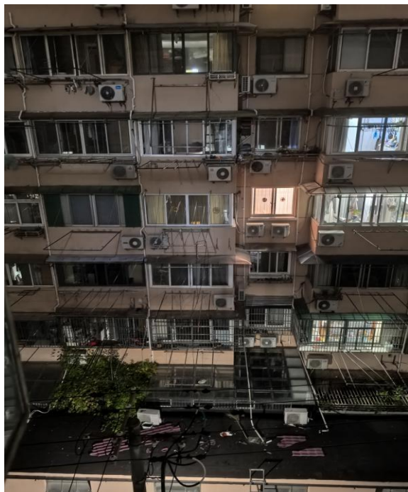
图一 38 号楼南侧照片
