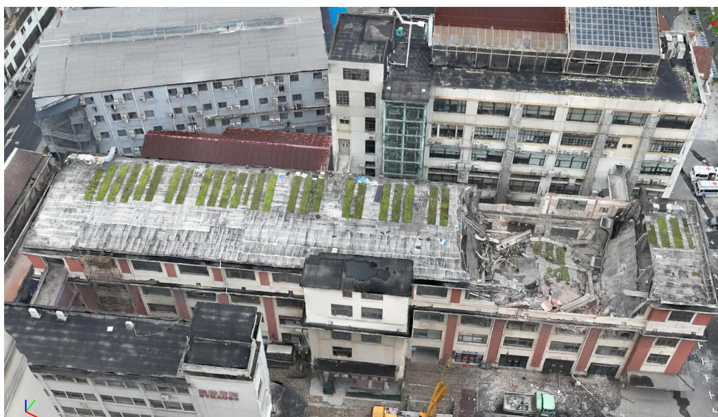
图1 事故房屋俯视图
