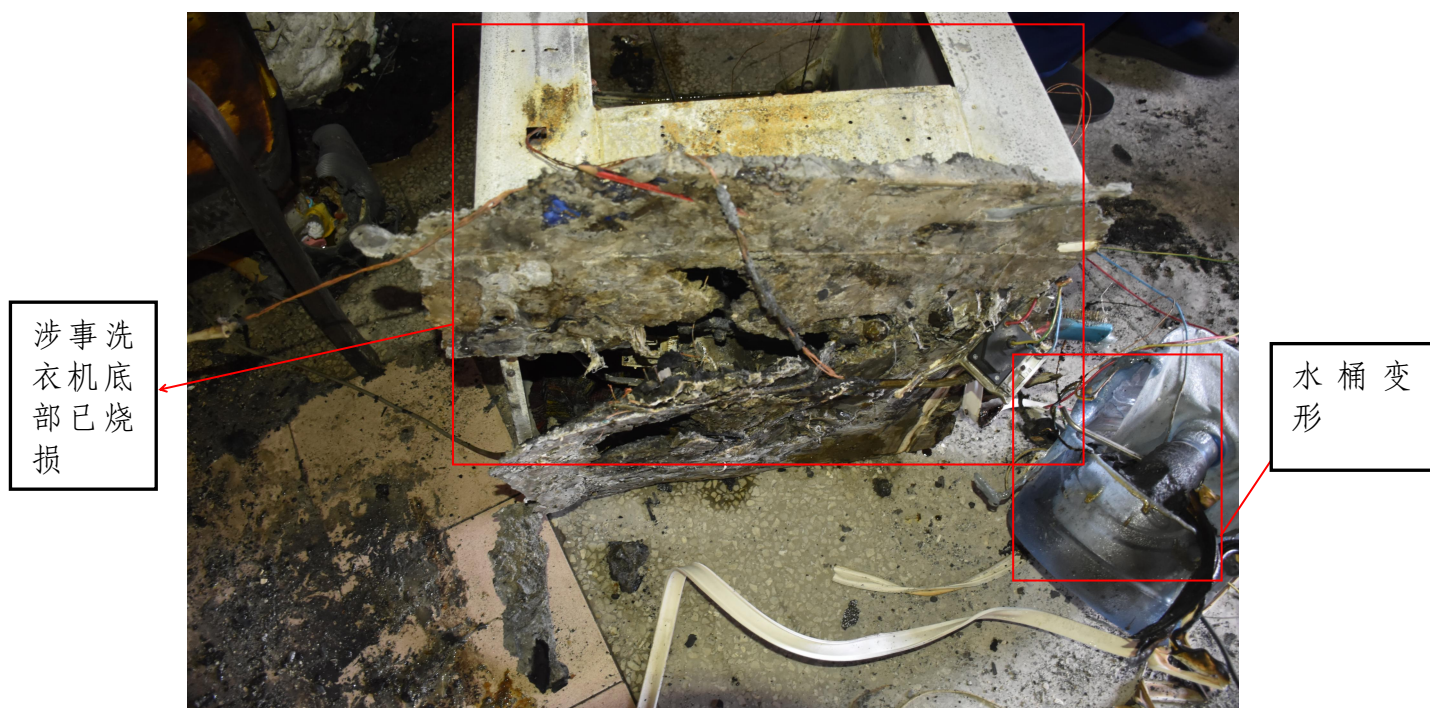
图7 事故现场中烧焦的洗衣机底部
