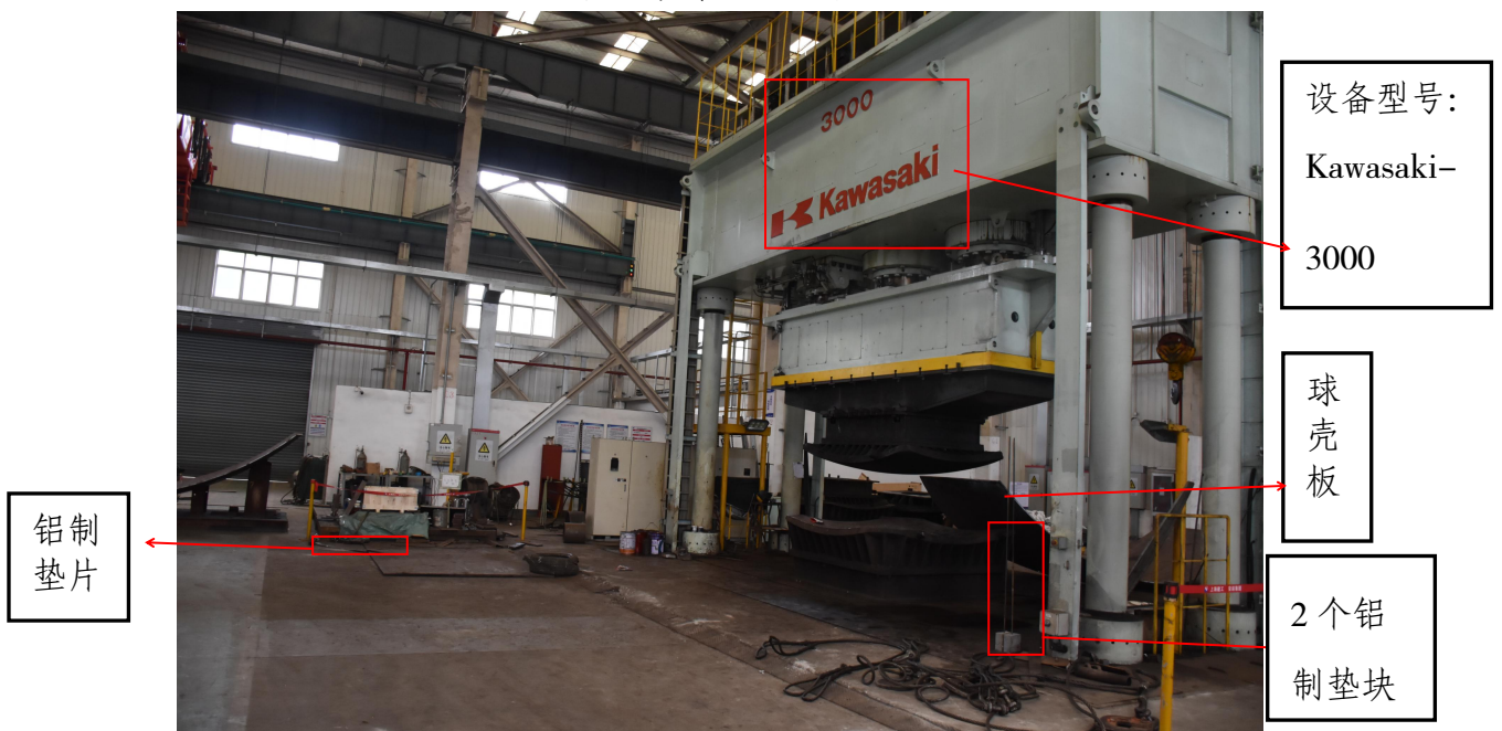
图6 事故现场情况
