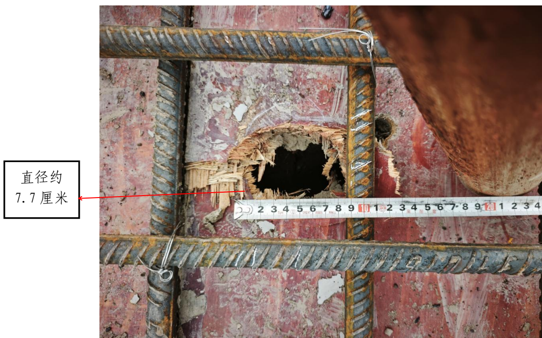
图 8 支架西北侧竖向圆管附近模板孔洞
