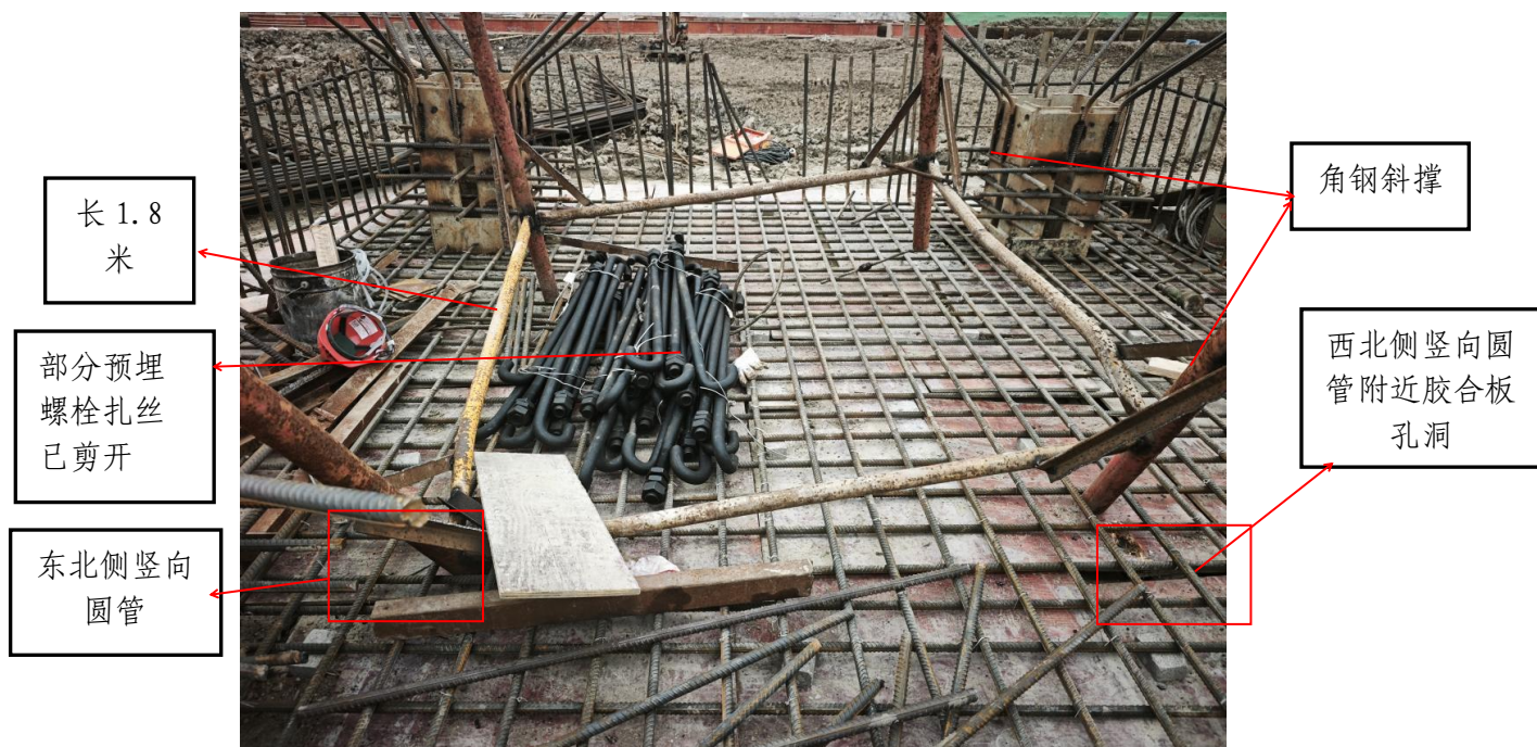
图 6 支架北侧两根竖向圆管位置情况
