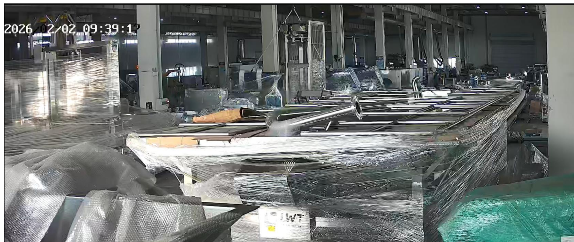
图 20 南侧杀菌釜起吊（第一吊）时吊带状态（时间：09 时 39 分 17 秒）
