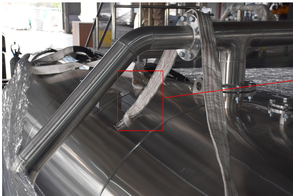
图12 涉事杀菌釜上方吊带断裂
