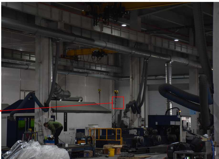
图16 涉事装卸车间西北角监控
