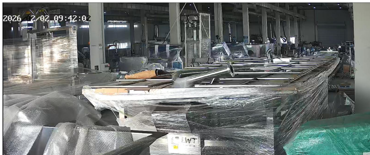
图 21 南侧杀菌釜起吊（第一吊）时吊带状态（时间：09 时 42 分 02 秒）
