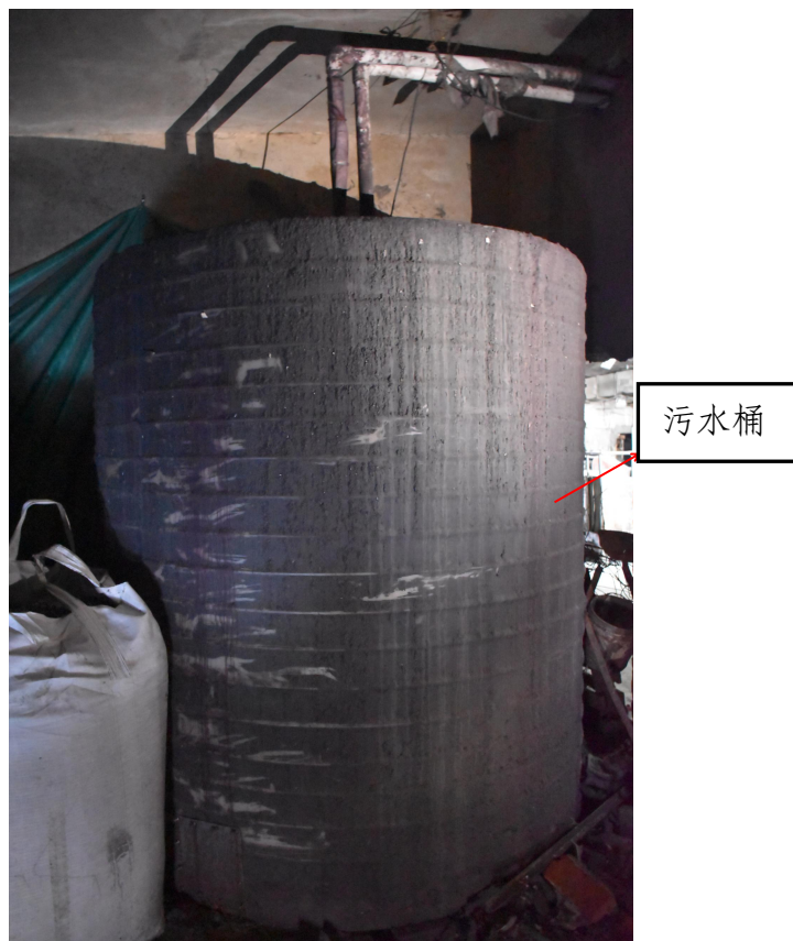
图13 厂房西侧污水桶
