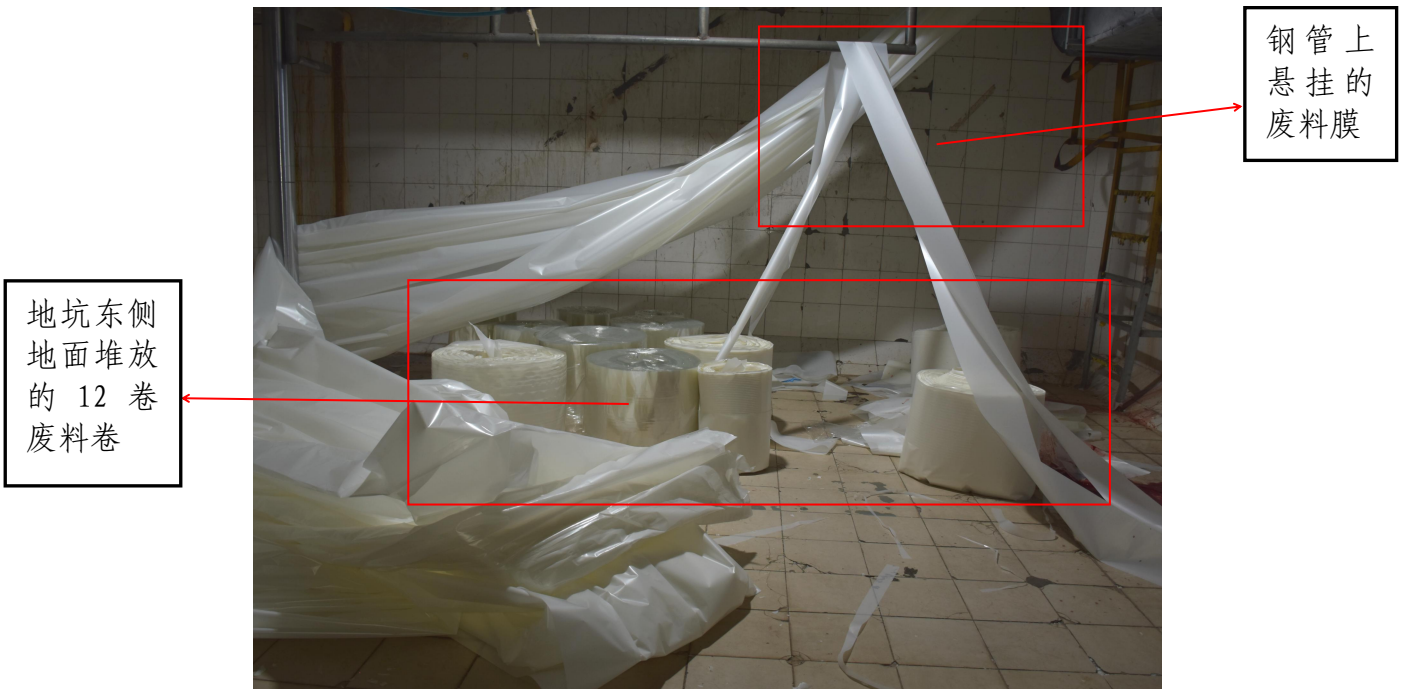
图8 地坑内堆放的废料卷及散落的废料
