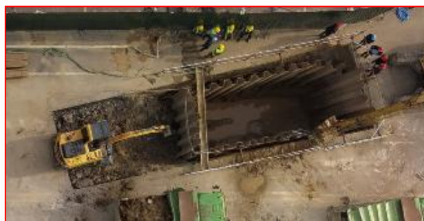
图10 开挖沟槽平面图
