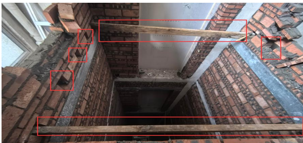
图 11 6 层墙体预留孔洞及遗留方木
