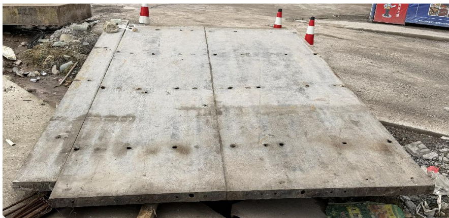
图 10 2 号边拆除的内模板（内表面）
