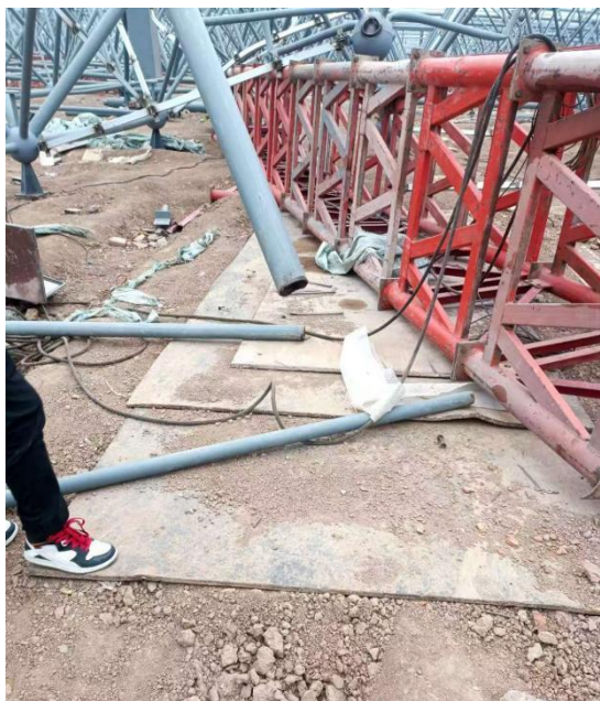
图 6 顶升支架（5 号）底部 设置 3 层钢板
