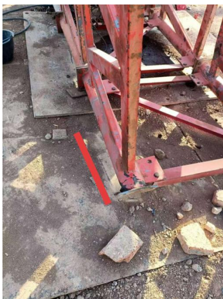
图 8 其他顶升支架底部 设置 2 层钢板
