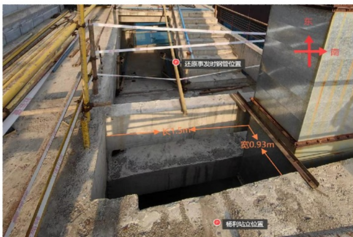
图2 现场勘察照片
