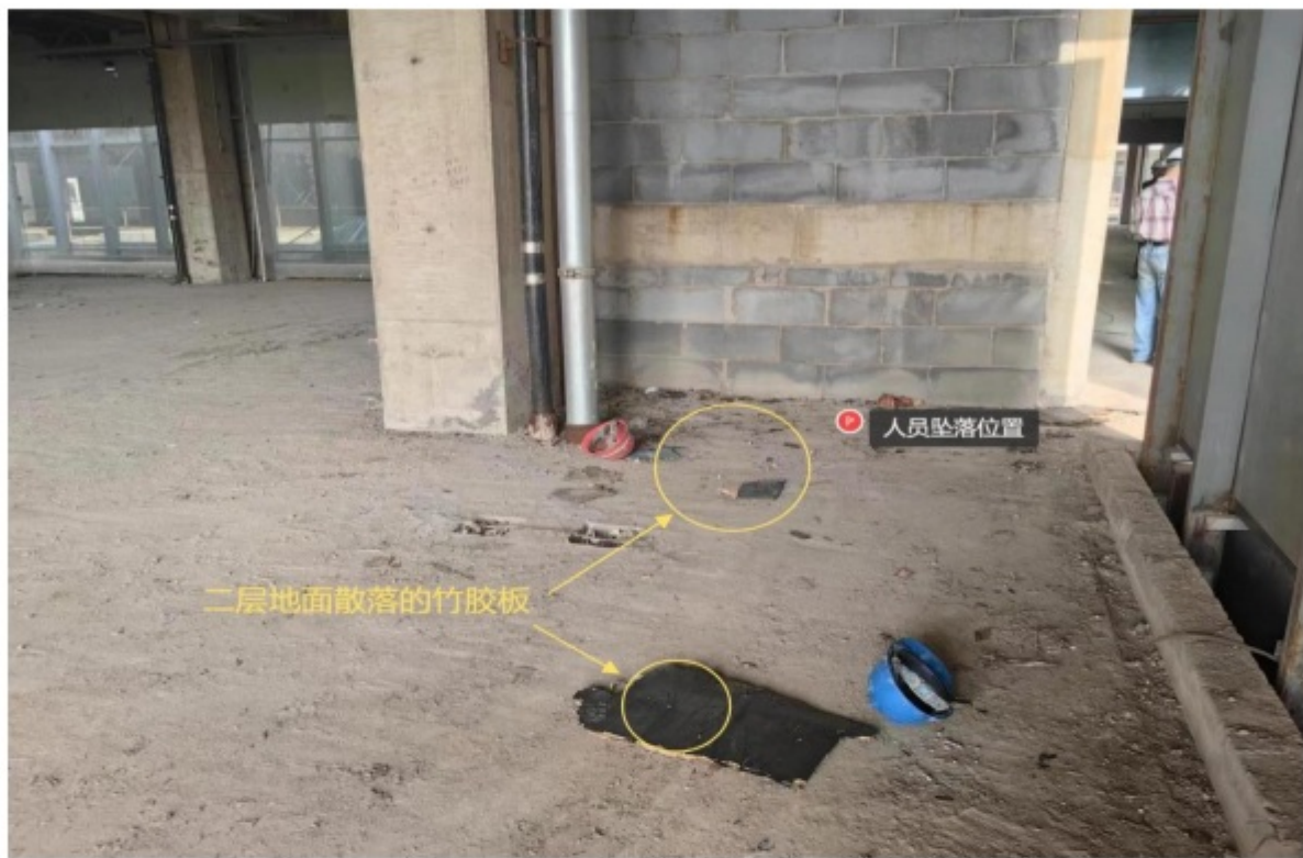
图5 现场勘察照片
