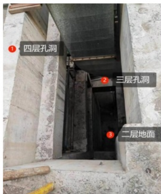
图3 现场勘察照片
