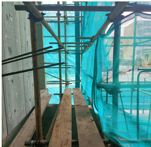
窗井洞口覆盖 3 块木质盖板
