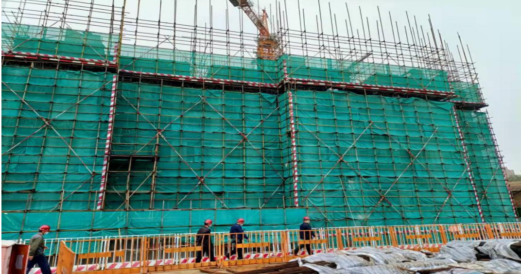
事发工地施工现场照片
