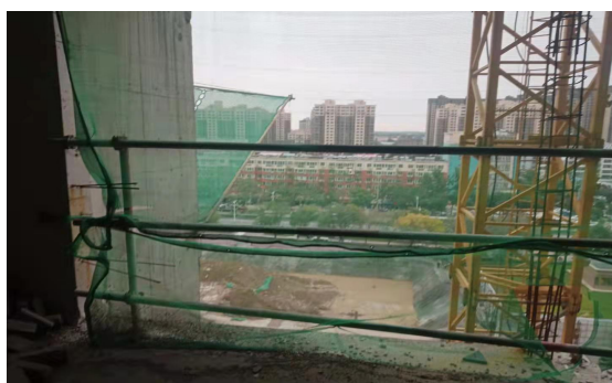
评估组对施工现场进行检查
