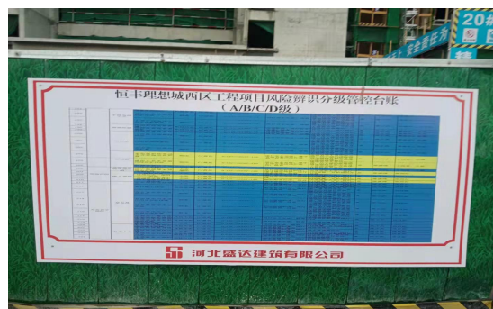
评估组对施工现场进行检查
