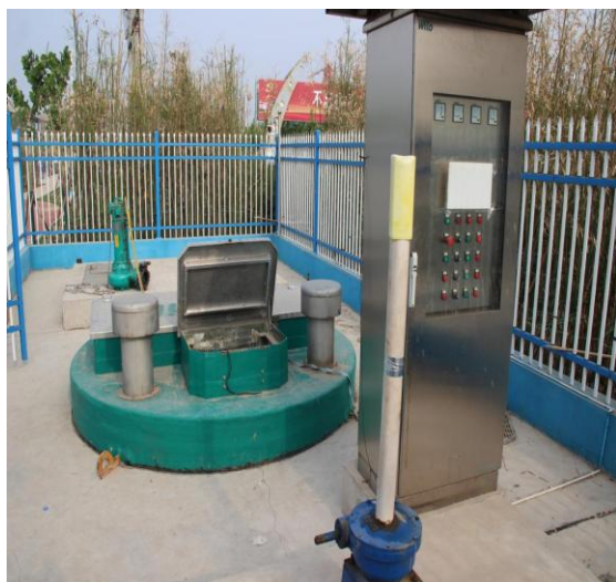
4 号一体化泵站外部
