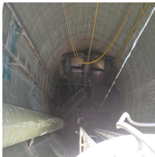
4 号一体化泵站筒体内部
