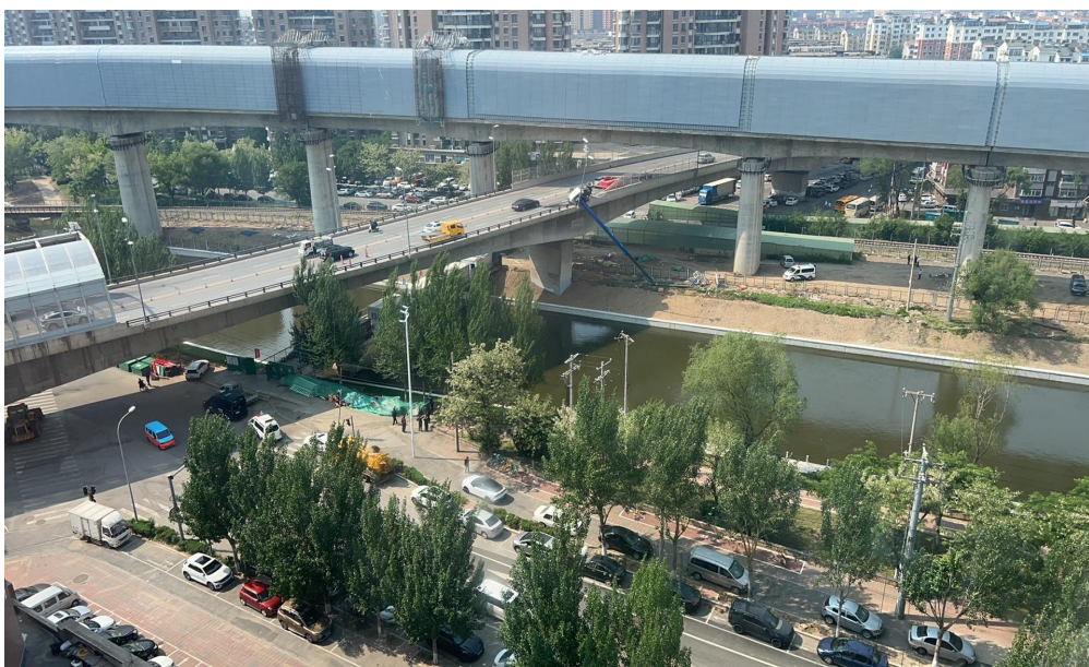
图4 小什字街跨线桥事故现场
