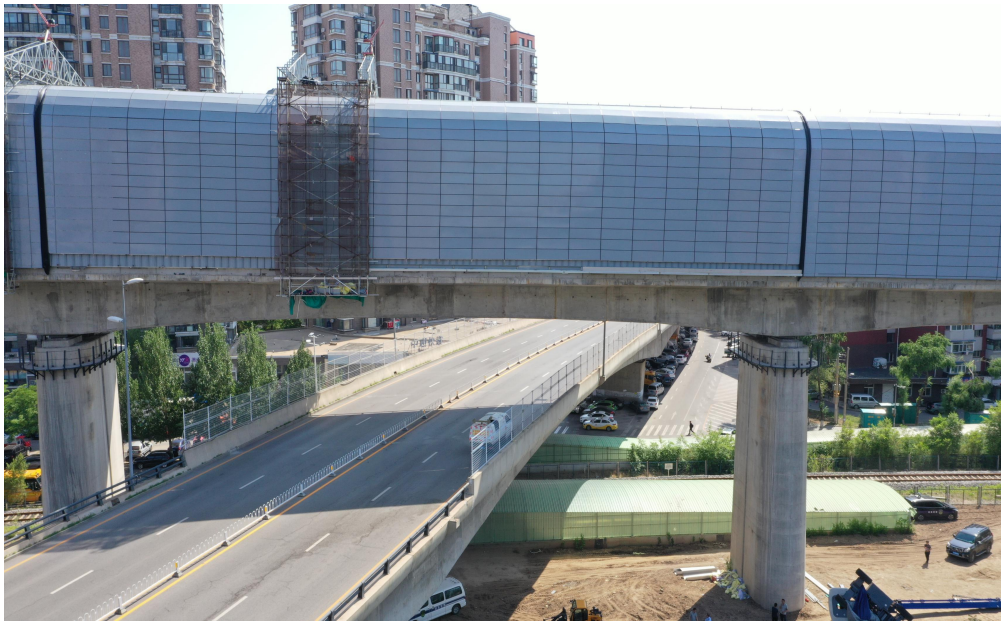
图 2 沈东特大桥全封闭声屏障工程
