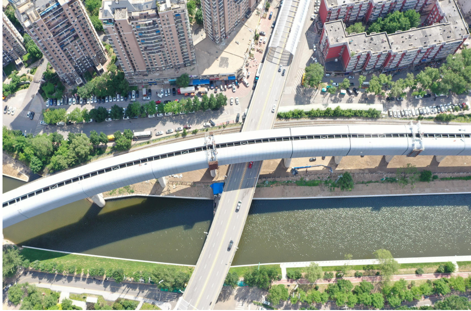
图1 声屏障上部安装工程（工农路小什字街跨线桥）
