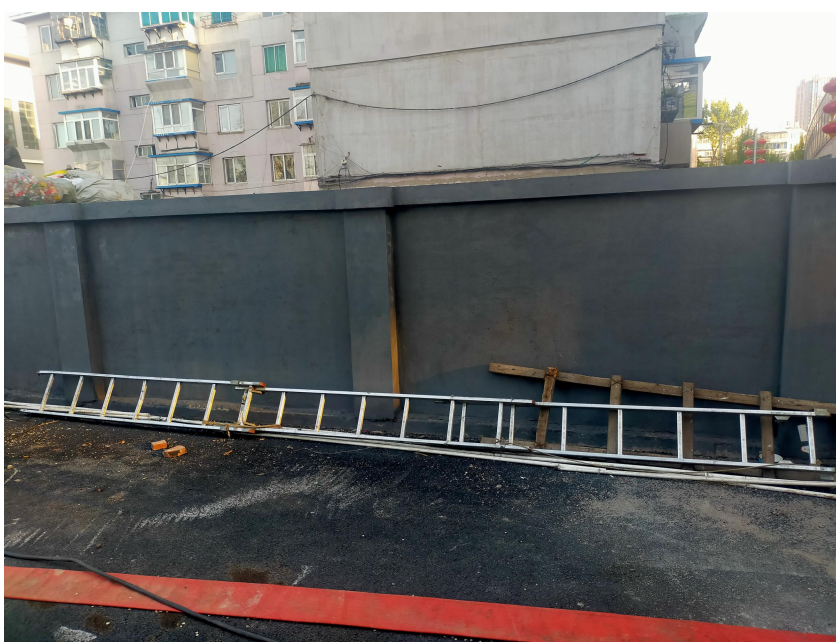
发生事故的排水井（上一图）和下井使用的扶梯 ⑤
