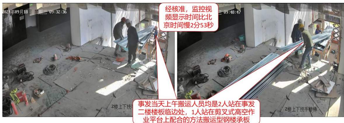
图4 事发当天上午作业人员搬运型钢楼承板方法视频截图
