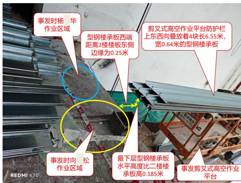
图 13 向某松和杨某华事发时搬运的型钢楼承板勘查图
