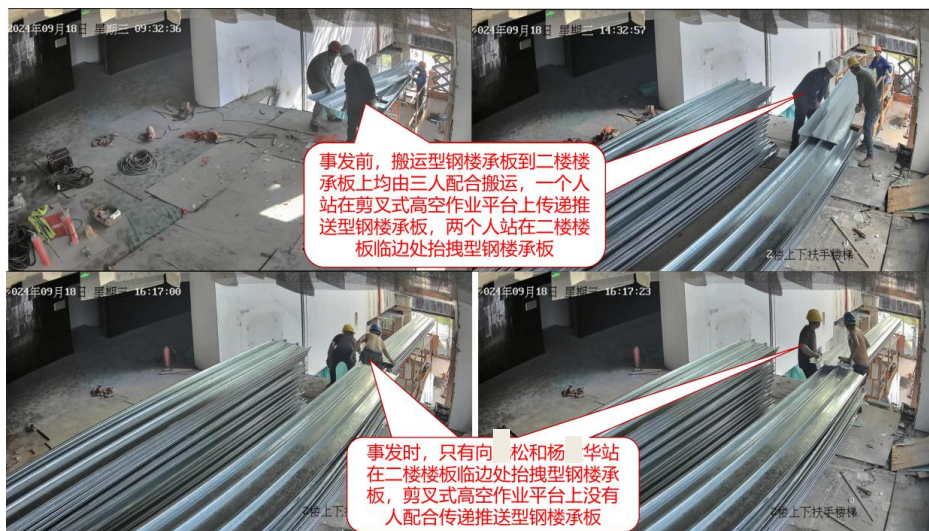
图 16 事发前、事发时型钢楼承板搬运方法监控视频截图
