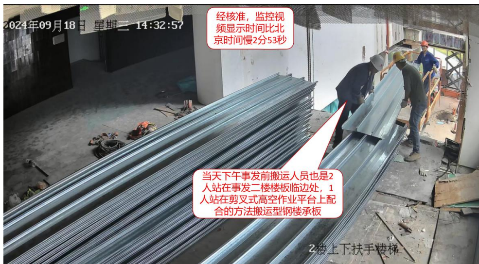
图 5 当天下午事发前作业人员搬运型钢楼承板方法视频截图
